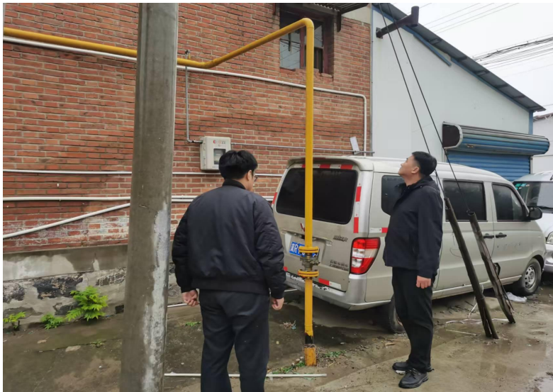
图 3—8 驻村第一书记与村干部检查燃气管道
